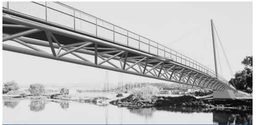
Nová lávka přes Berouňku od Josefa Pleskota, v Radotíně se objeví v půlce roku 2022
